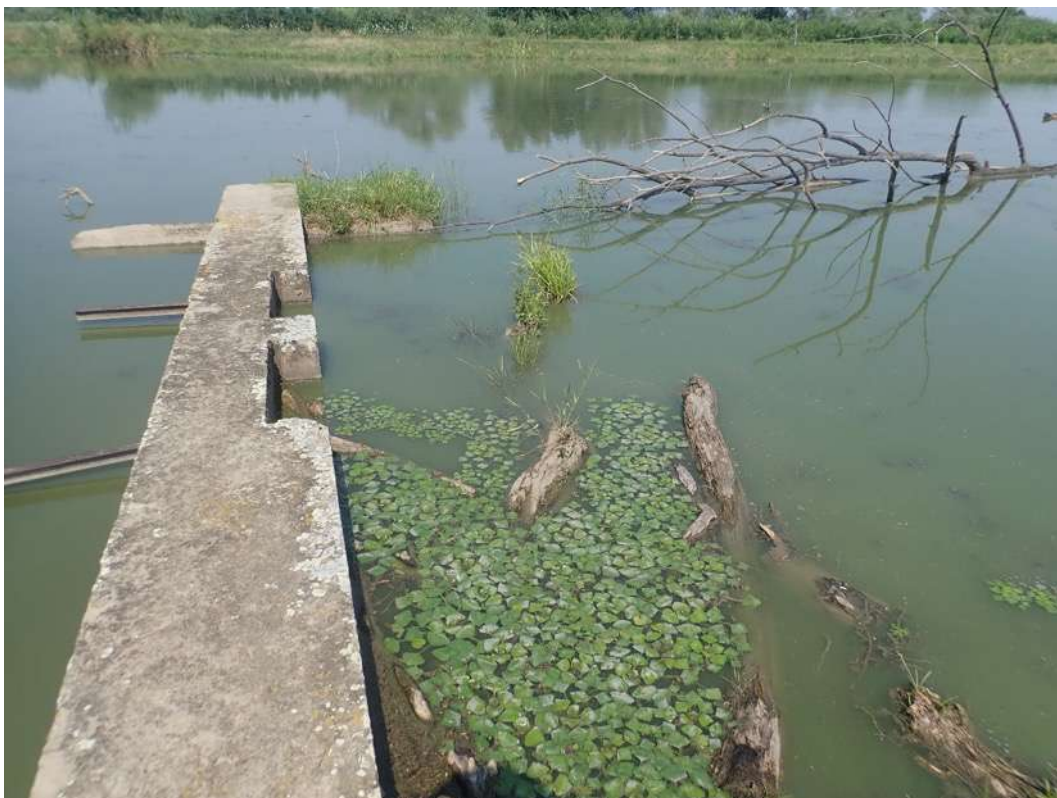
2. kép. Az egyik elbontandó vasbeton műtárgy és környezete
