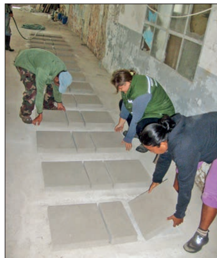
Betonelemgyártás, járólapok készítése
